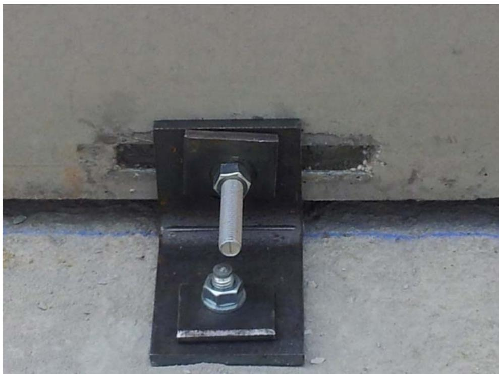
En cas de nécessité, des liaisons avec le mur seront réalisées au moyen de barres d'attente ancrées dans la dalle ou la fondation et scellées dans des réservations de type « tube hydra ».
