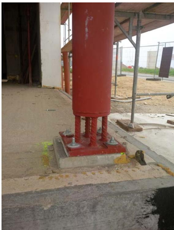
Coupure thermique pour colonnes métalliques
