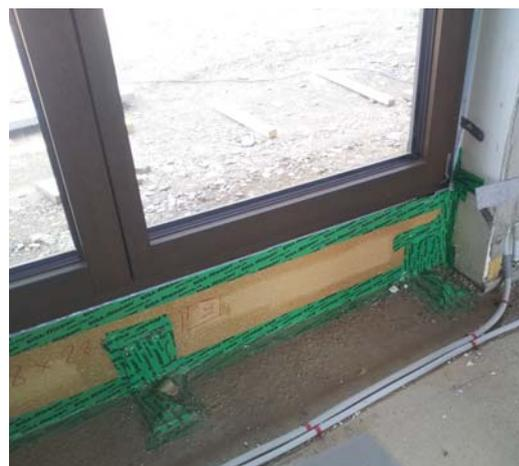
Possibilité de réaliser sur demande des décaissements spéciaux pour la fixation des seuils.
