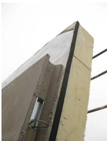
La fixation et le réglage des murs en pied de mur seront réalisés par des rails d'ancrage incorporés dans le voile en béton et fixés à la dalle ou à la fondation porteuse par l'intermédiaire de cornières métalliques et de chevilles.
