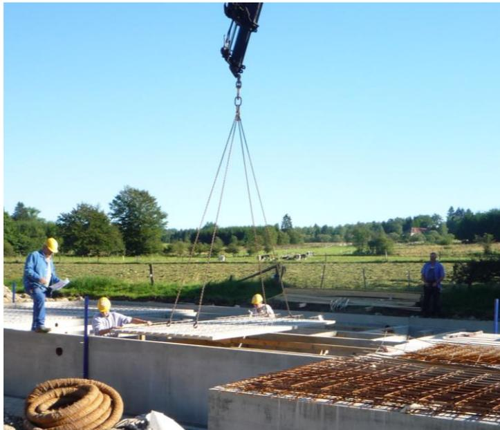
Les prédalles prendront appuis sur les murs en béton porteurs, sur les poutres et sur les étaçons de montage placés aux entre-distances indiquées avant la pose de prédalles.
