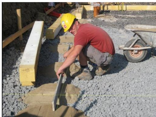
Le coffrage isolant du radier sera réalisé de manière continue sur tous le périmètre du radier et tous les jeux entre les blocs eux-mêmes et le gravier isolant seront fermés sur toute l'épaisseur par une mousse de polyuréthane expansible moussée sur chantier.
