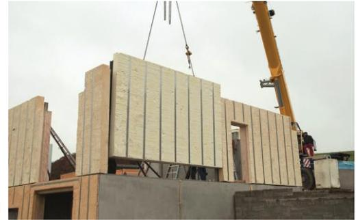
Le système PAMAFlex consiste en une combinaison de béton préfabriqué et d'une isolation en polyuréthane et fournit tous les éléments de construction, de la cave au toit.
