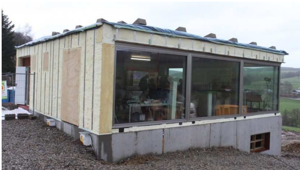
Das Passiv-Massiv-Musterhaus in Alfersteg im Bau.
